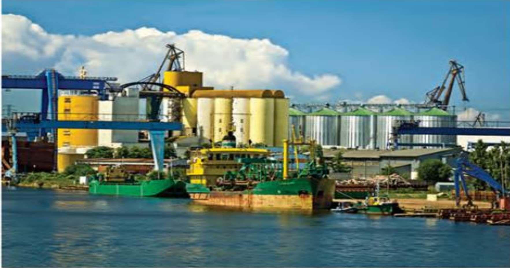
Resim 1.5 Liman İçinde Yer Alan Bir Tahıl Silosu
